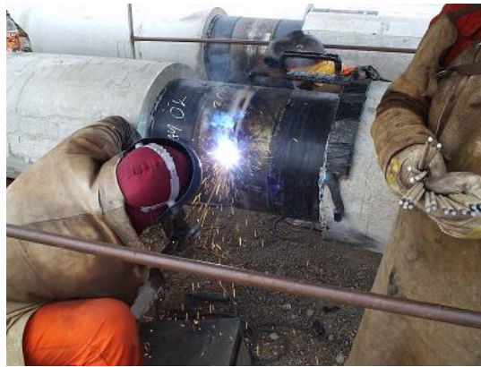
Figura 3- Gasoduto Coari-Manaus trecho B2 em Manacapuru
