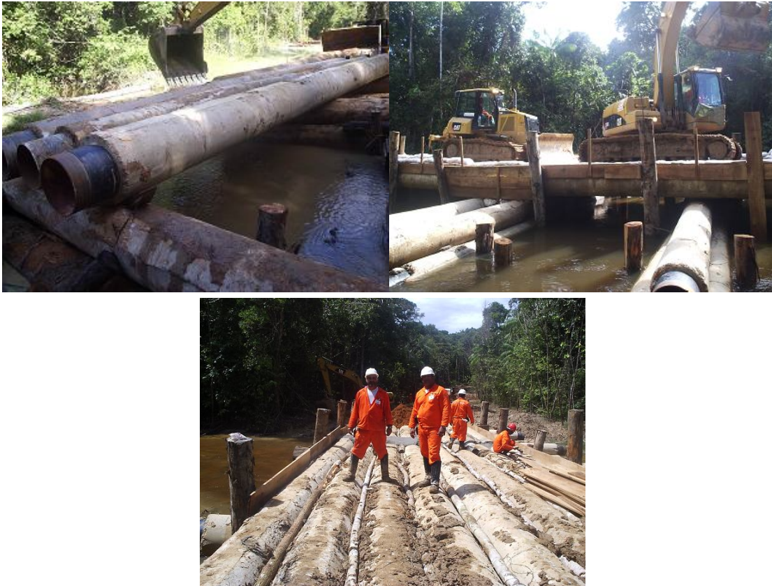
Figura 7: Construção da Ponte sobre o Igarapé do Cedro
