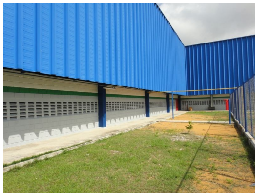
Figura 2 – Placas zincadas y paredes de concreto
