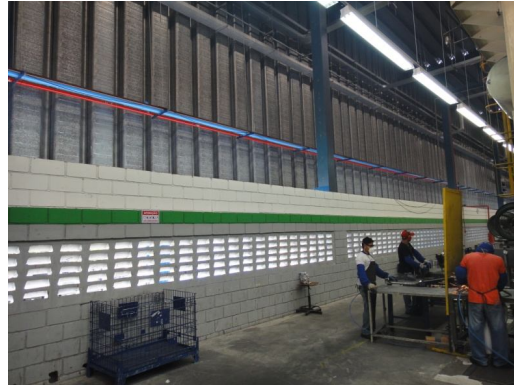
Figura 3 – Estructuras metálicas y cubierta con pantallas de zinc y policarbonato
