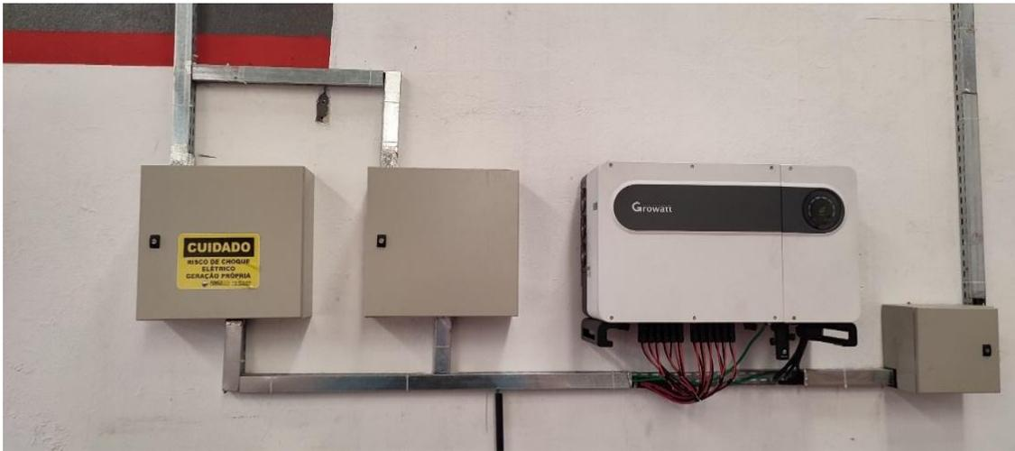
Figura 4.11 - Montagem do inversor e proteções.
